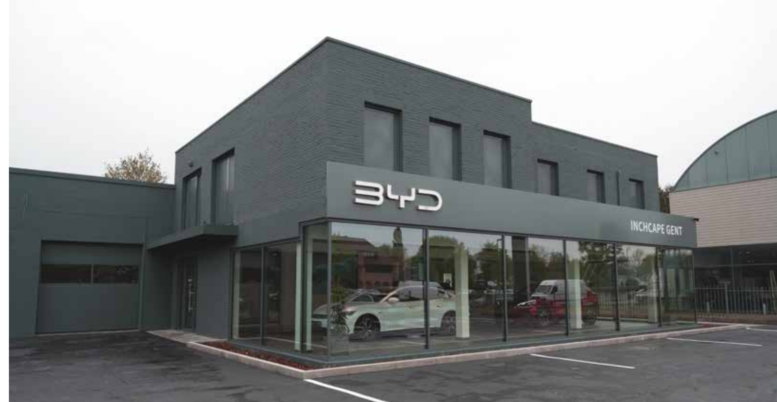
De nieuwe BYD vestiging in Sint-Martens-Latem waar installatiebedrijf Airco Lemmens op heel korte tijd de klimatisatie verzorgde.
